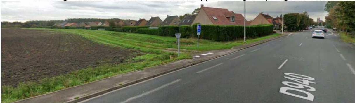
Vue sur Loon-Plage depuis la RD940 (source : google-street-view)
